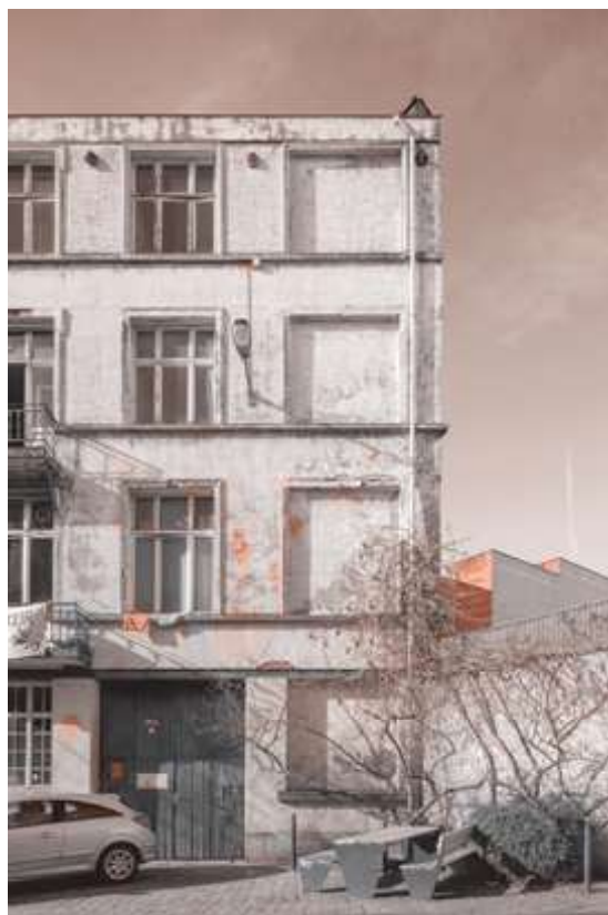
▲ SVC «Heyvaert - Poincaré» - Woningen Waskaarsstraat - Foto van de huidige situatie. Séverin Malaud © urban.brussels
